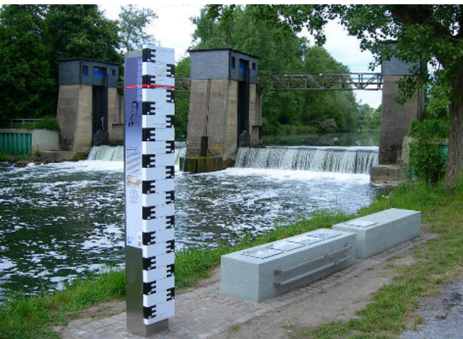
Zeitpegel und Installation am Stauwehr Beckinghausen (Station 01)
