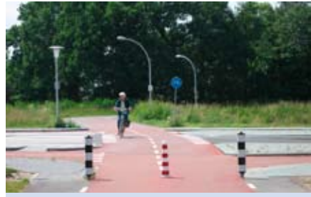
Hier sind die Verhältnisse einmal umgedreht worden: Die Radverkehrshauptachse wird bevorzugt über eine Hauptverkehrsstraße des Autoverkehrs geführt (Zwolle).
