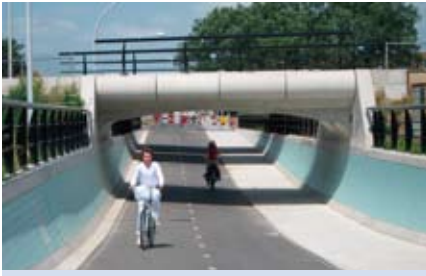
Diese lichte und schön gestaltete Unterführung unter einer Hauptverkehrsstraße lässt erst gar kein unwohles Gefühl aufkommen (Zwolle).
